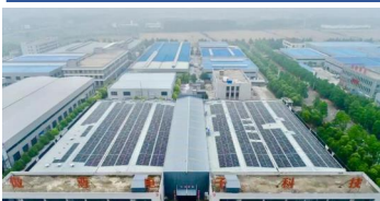
亳州傲尊电子1.1MW工商业光伏项目
